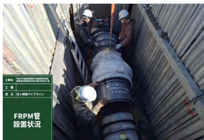
尼ヶ崎南パイプライン地区 施工状況
