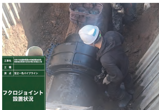
宮之一色パイプライン地区 施工状況
