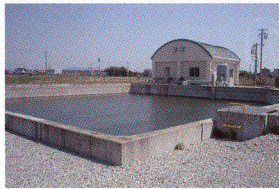
高木工区 (仿僧西) ポンプ場 (竜洋町岡地内)
