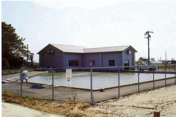
宮之一色工区ポンプ場（豊田町一言地内）
