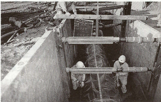
※ パイプ布設工事
