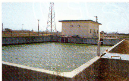
前野工区ポンプ場(磐田市前野地内)
